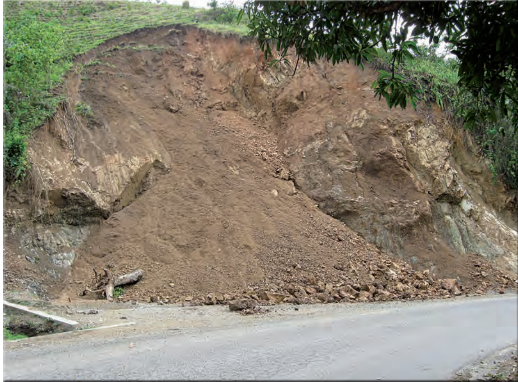
PHOTO 35 - GLISSEMENT DE TERRAIN
