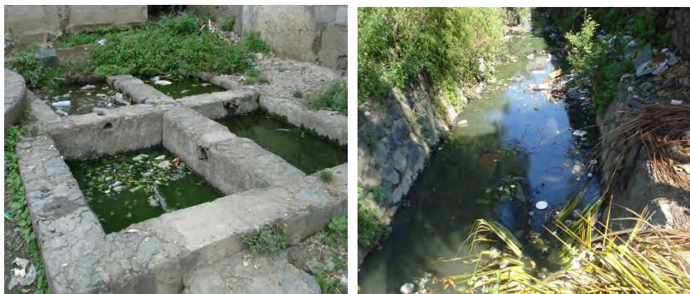
Photo 24 : Vue partielle des infrastructures et canaux contenant des eaux usées au niveau du centre ville de Limbé
