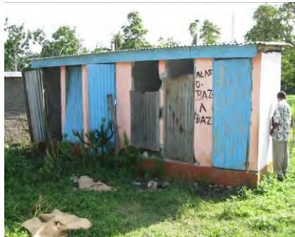
Toilettes d'une école
