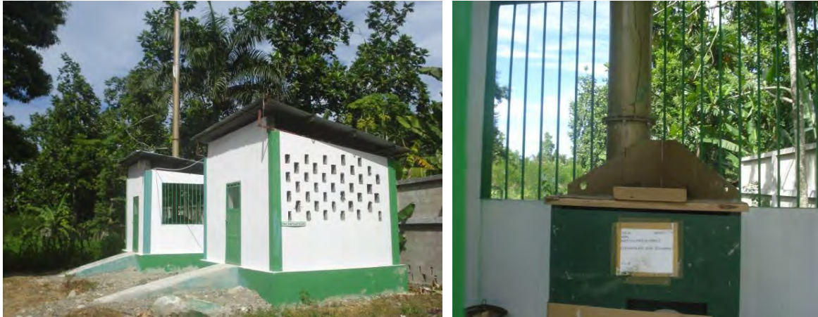
Photo 18 : Incinérateur et salle de stockage des déchets (Hôpital St Jean)
