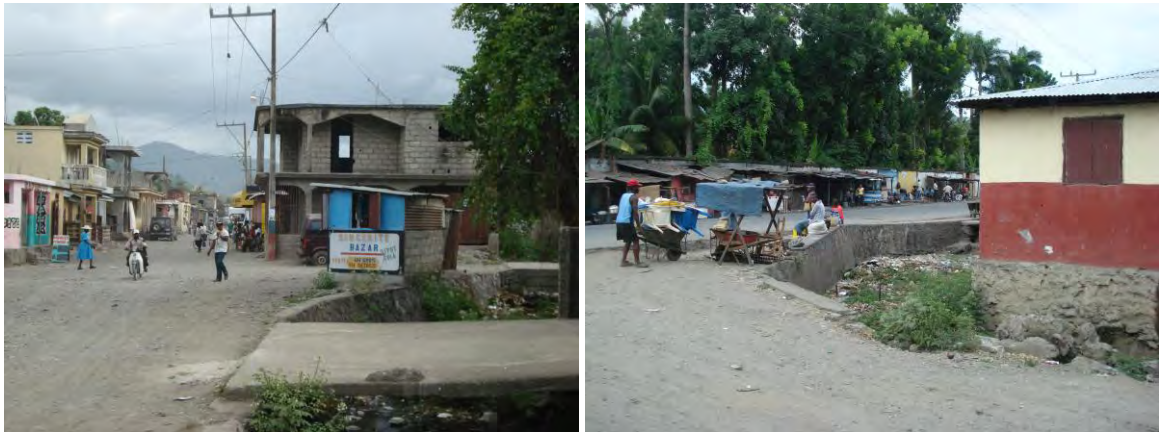
Photo 8 : Vue de l'aspect multifonctionnel des drains (dépotoir et leur périmètre sert comme espace de commerce et de construction)
