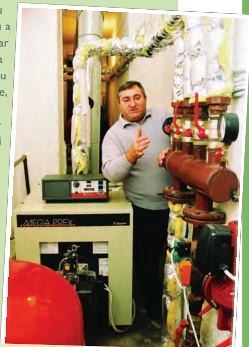
Cornel Mot, președintele asociației de proprietari de la scara D, în încăperea unde a fost montat boilerul
