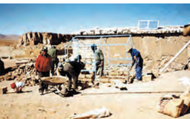
Construcción de secadora de charque
