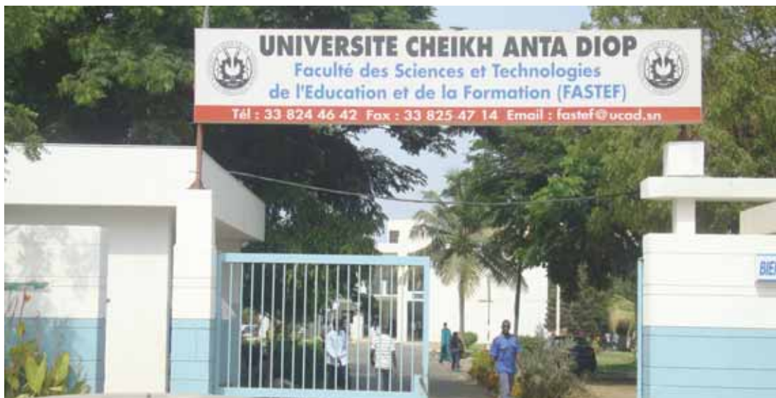
Fig. 2- Entrée principale de la FASTEUF
