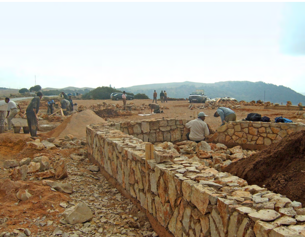
Travaux en cours dans le balcon d'Ito.
