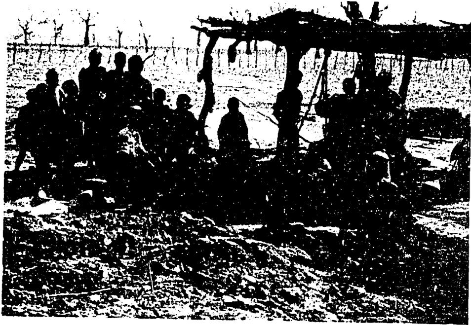
Fig. 3.25. Puits creusé dans le "Continental Terminal" près de Koutia Bâ dans le Ferlo. Ce puits a 40 m de profondeur et n'a atteint aucune nappe phréatique.
