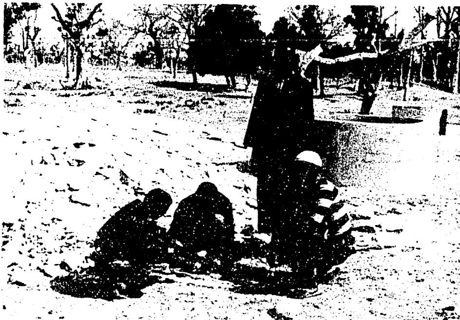
Fig. 3.22. Puits à la mission catholique de Ndiaganiao. Le puits est creusé dans des marnes et des calcaires fossilifères datant probablement du Paléocène. A 8 m de profondeur, le puits est toujours sans eau. Le puits visible en arrière plan a 13 m de profondeur et présente seulement quelques traces d'eau.
