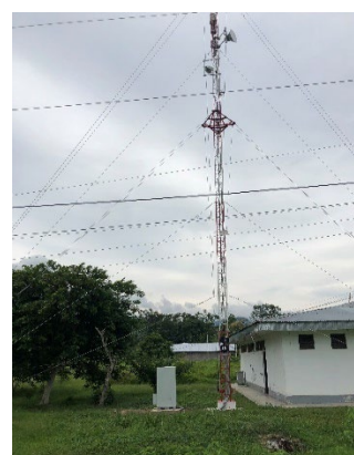
Alto el Sol. Escasa señalización
