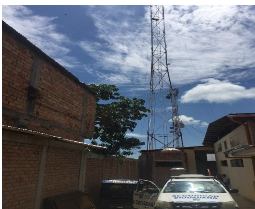
Lamas. Torre y tanques de agua
