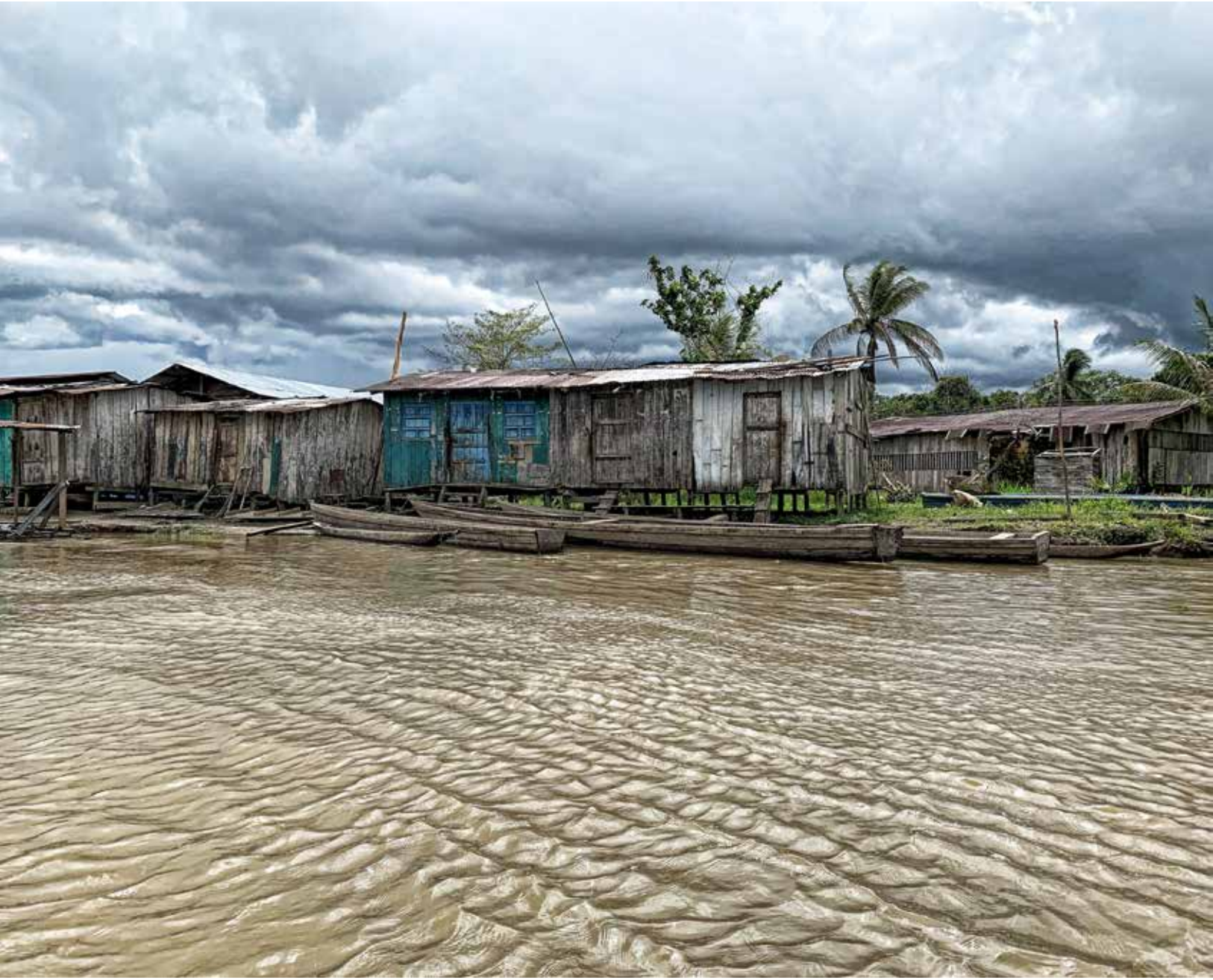
Edificaciones en zona rural de Bojayá
