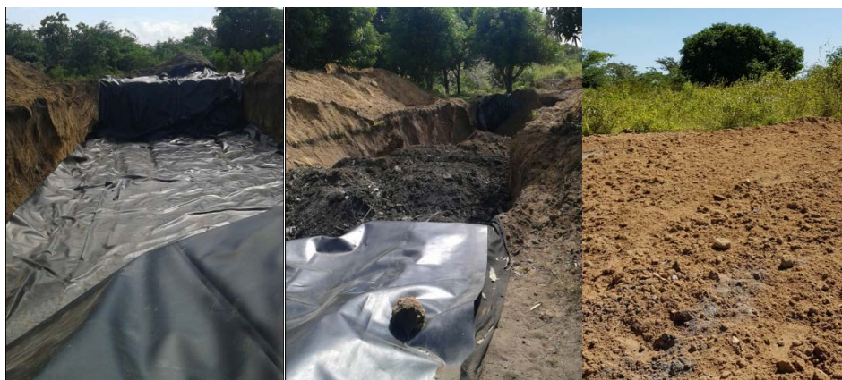
Secuencia de la construcción y sellamiento de la celda de disposición
