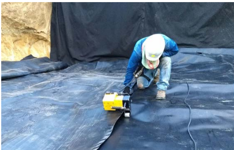
Termosellado de la geomembrana
