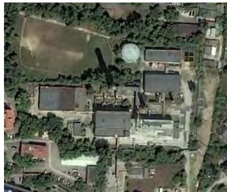
Reprezentarea 54: Centrala Termică CT-Sud, Chișinău
