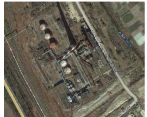
Reprezentarea 55: Centrala Termică CT-Est, Chișinău
