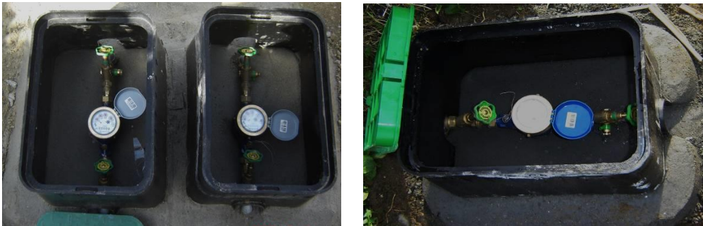
Figura 13. Instalimi i ujëmatësave në shtëpi private
