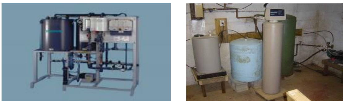
Figura 8. Sisteme dozimi automatik me klor të lëngshëm
