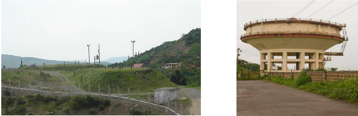
Figura 9. Rezervuarët e ujit nëntokesorë dhe mbitokësore
