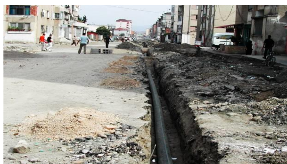
Figura 10. Shtrim tubacioni polietileni në rrugë
