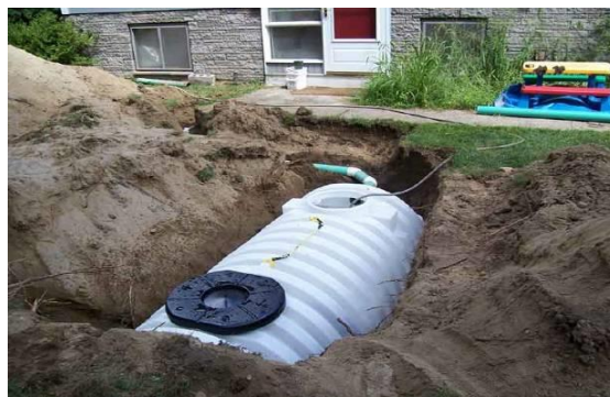
Figura 24. Gropë septike e parafabrikuar
