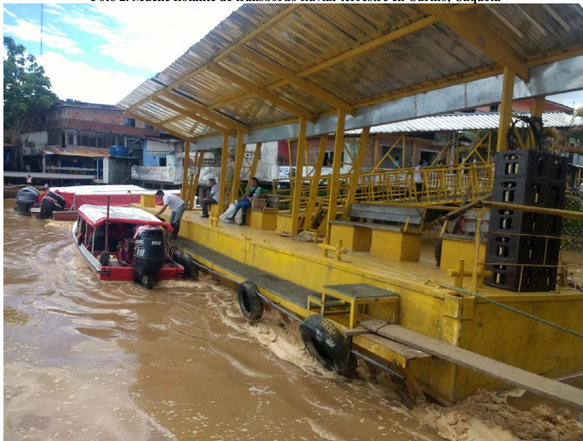
Foto 2. Muelle flotante de transbordo fluvial-terrestre en Curillo, Caquetá
