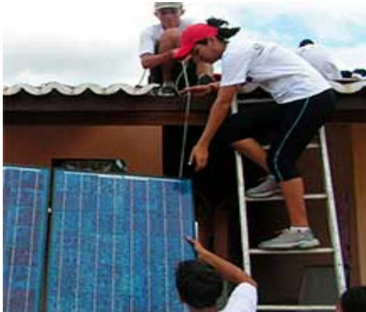
Installation de panneaux solaires au Brésil. Crédit photo : USAID
