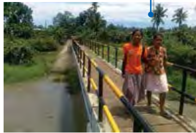
Purok Panaghiusa Footbridge Tabunan, Zamboanga del Sur
