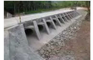
Ngan Spillway (Overflow Structure) Compostela, Compostela Valley
