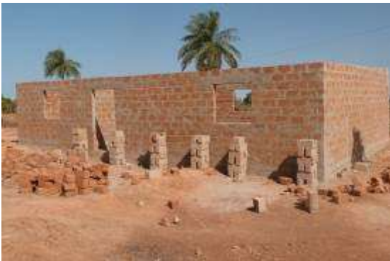
Salle informatique en construction ( Mars 2014 )
