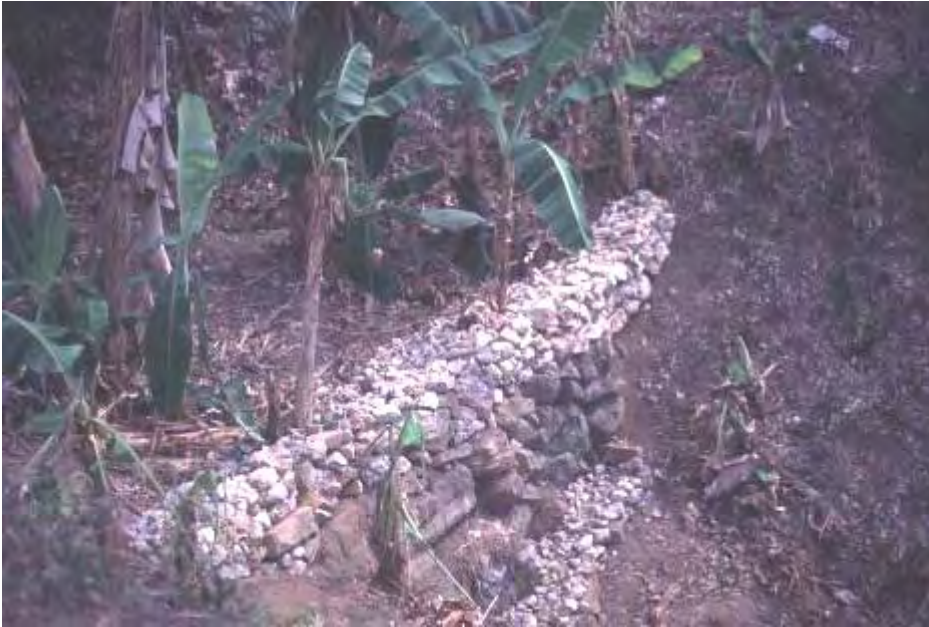
Figure 5. Une digue de ravin avec des bananes plantains
