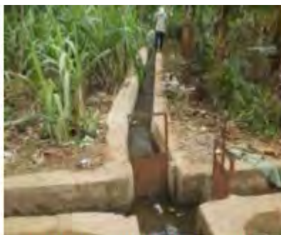
Extension toward Baujojn
