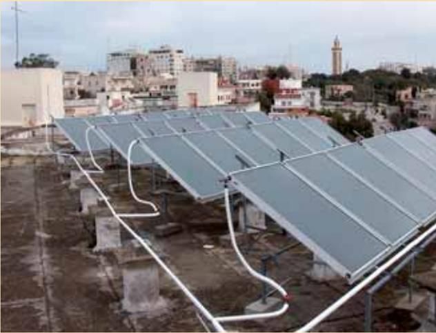
Installation collective de chauffe-eau solaires à éléments séparés - Source : CDER.
