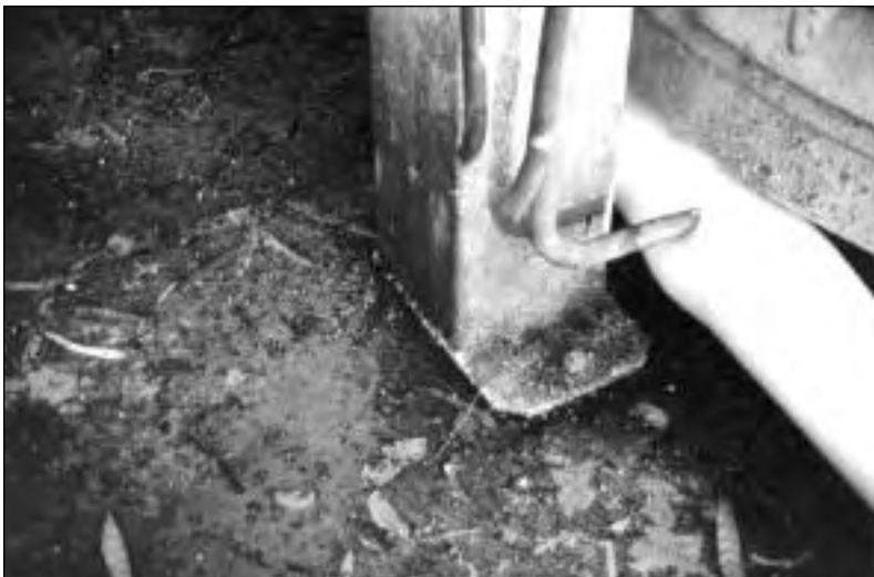
Fotografía 16. Detalle de conexión en los soportes
