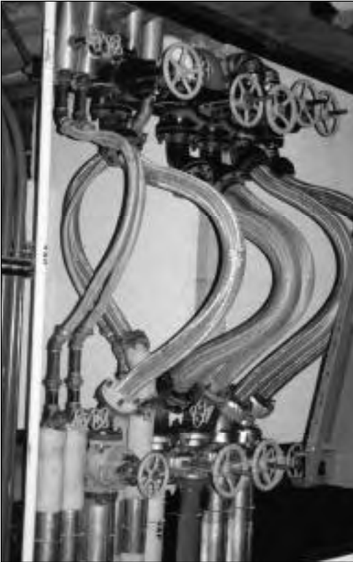
Fotografía 21. El uso de tuberías flexibles en zonas críticas como juntas de dilatación sísmica, uniones con equipos y cruce de edificios, ayuda a reducir la vulnerabilidad.
