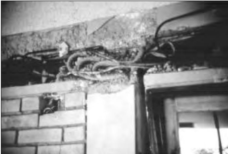
Fotografía 18. Efecto de columna corta
