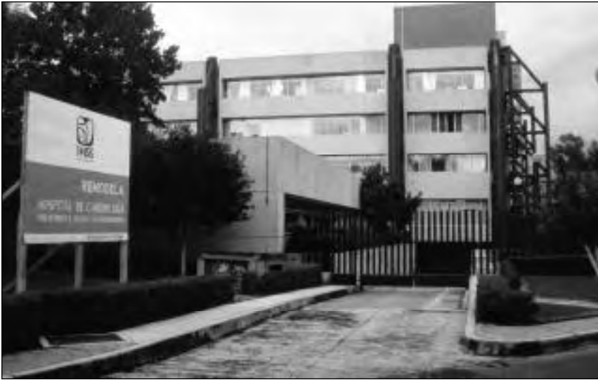
Fotografía 12. Hospital de Cardiología del Instituto Mexicano del Seguro Social que fue reforzado usando pórticos contrafuertes luego del sismo de México 1985.
