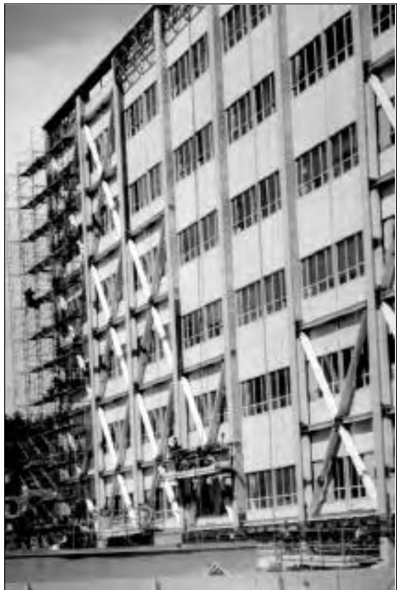
Fotografía 13. Refuerzo con diagonales
