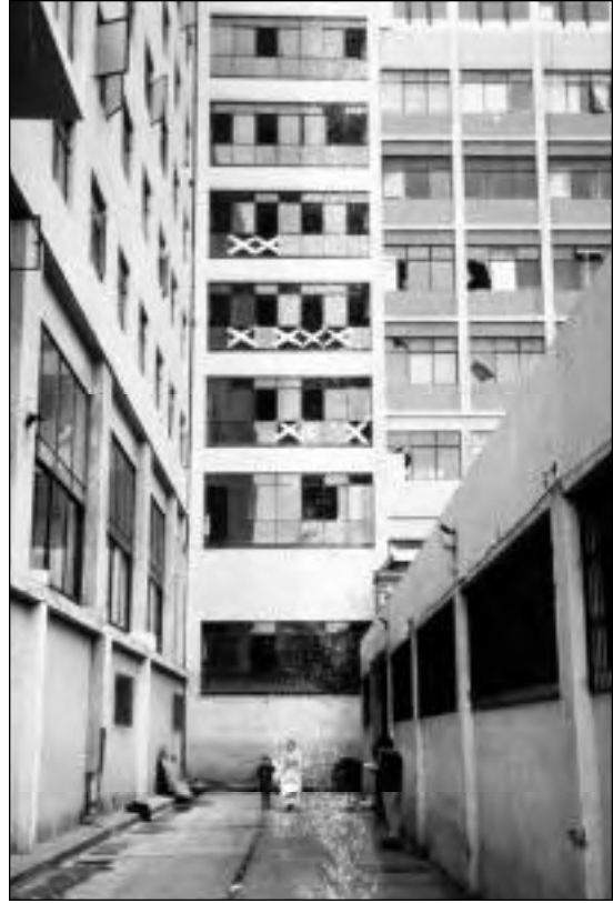
Fotografía 20. La rotura de vidrios puede causar daños a los ocupantes del hospital, así como obstaculizar las vías de circulación y evacuación.
