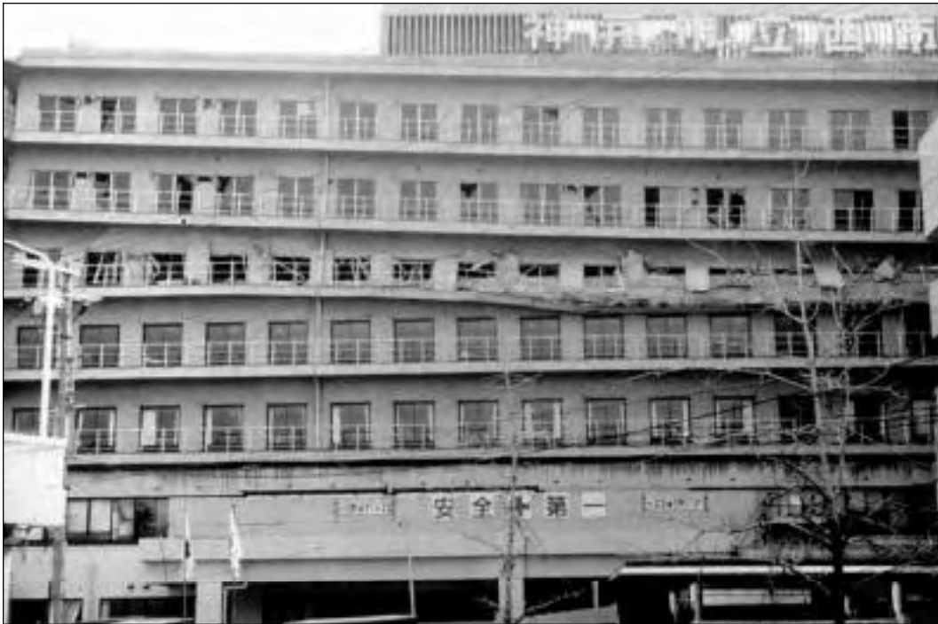
Fotografía 3. Colapso del Quinto Piso, Hospital Municipal de Kobe, 1995
