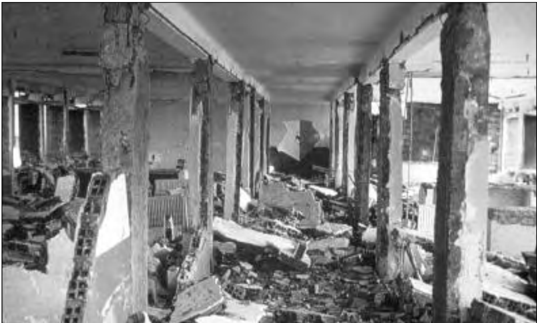
Fotografía 24. Muros destruidos por flexibilidad de la estructura
