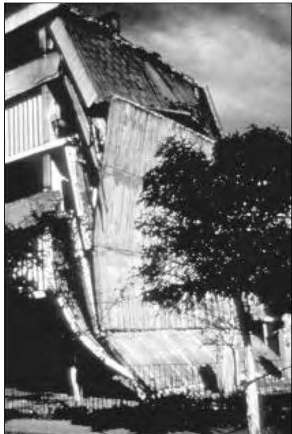
Fotografía 11. Colapso estructural debido a la discontinuidad de elementos verticales
