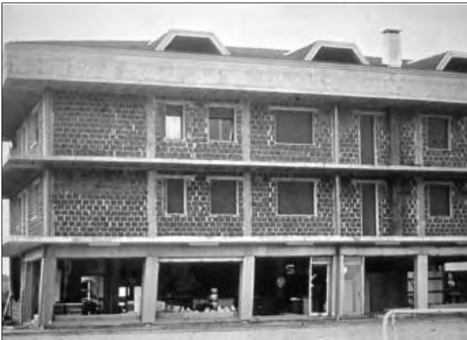
Fotografía 9. Falla en planta baja por piso suave
