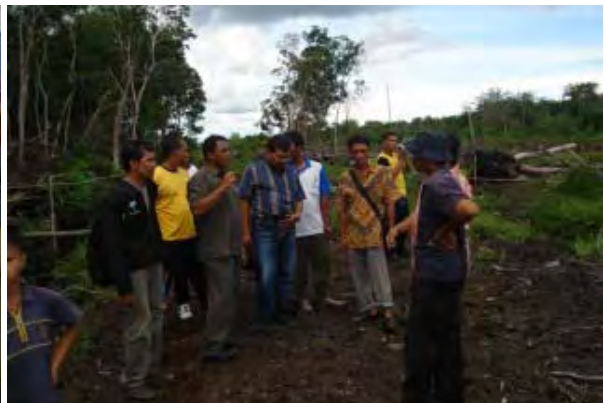
Inspeksi mendadak (Sidak) pembangunan jalan
