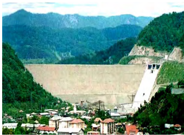
Sîriu Dam – r. Buzău
