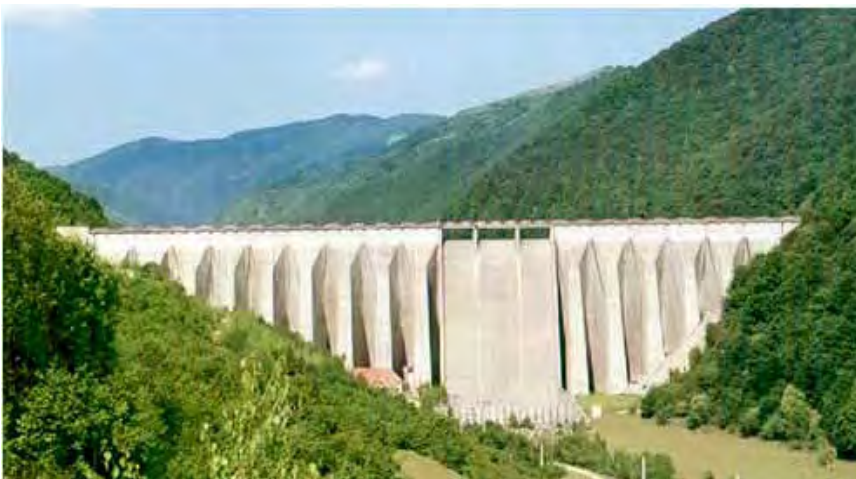
Gura Râului Dam – r. Cibin
