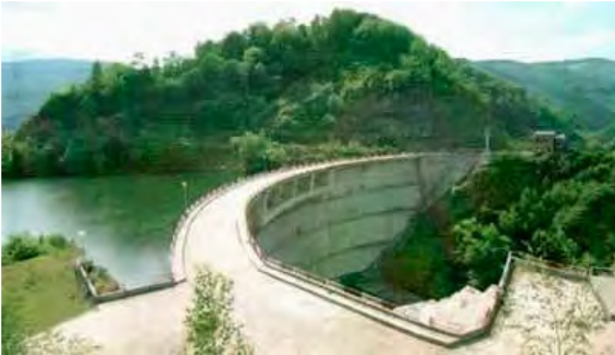
Tău Dam – r. Sebeș
