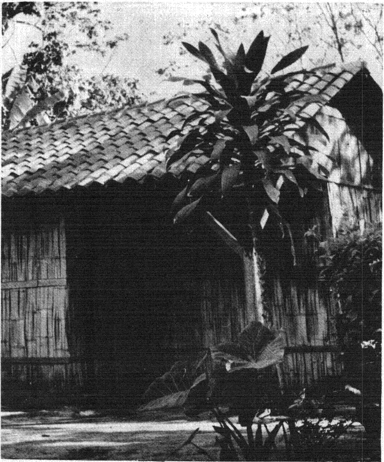
Figura 20. El techo de esta casa de bambú, en Guatemala, está cubierto con teja. Las "tablas" de las paredes están hechas de cañas de Bambusa vulgaris .
