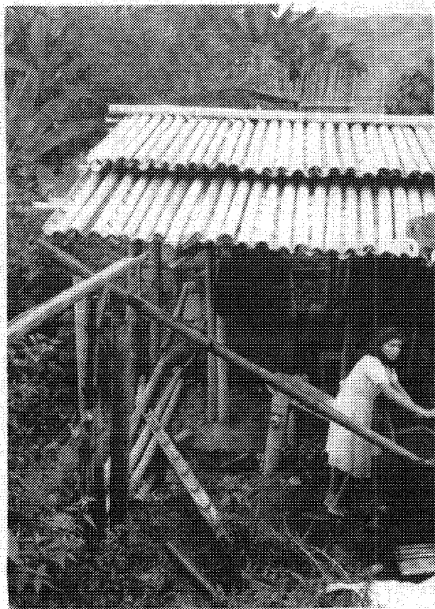
Figura 19. Las tejas del techo de esta lavandería rústica de Colombia, al igual que las canales que la surten de agua, son cañas de Guadua angustifolia , la especie de bambú silvestre que abunda en Colombia y Ecuador, cortadas a la mitad longitudinalmente.
