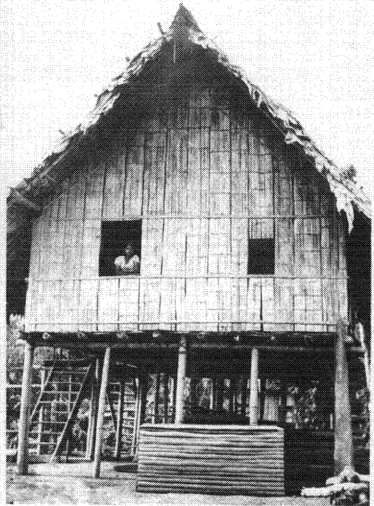
Figura 2. Esta barraca de las tierras bajas de Ecuador, está construida totalmente con bambú Guadua angustifolia de la región, desde los postes de cimentación hasta los cabrios y entramados. Los postes pueden dar servicio durante cinco años; las costaneras, durante varias décadas.
