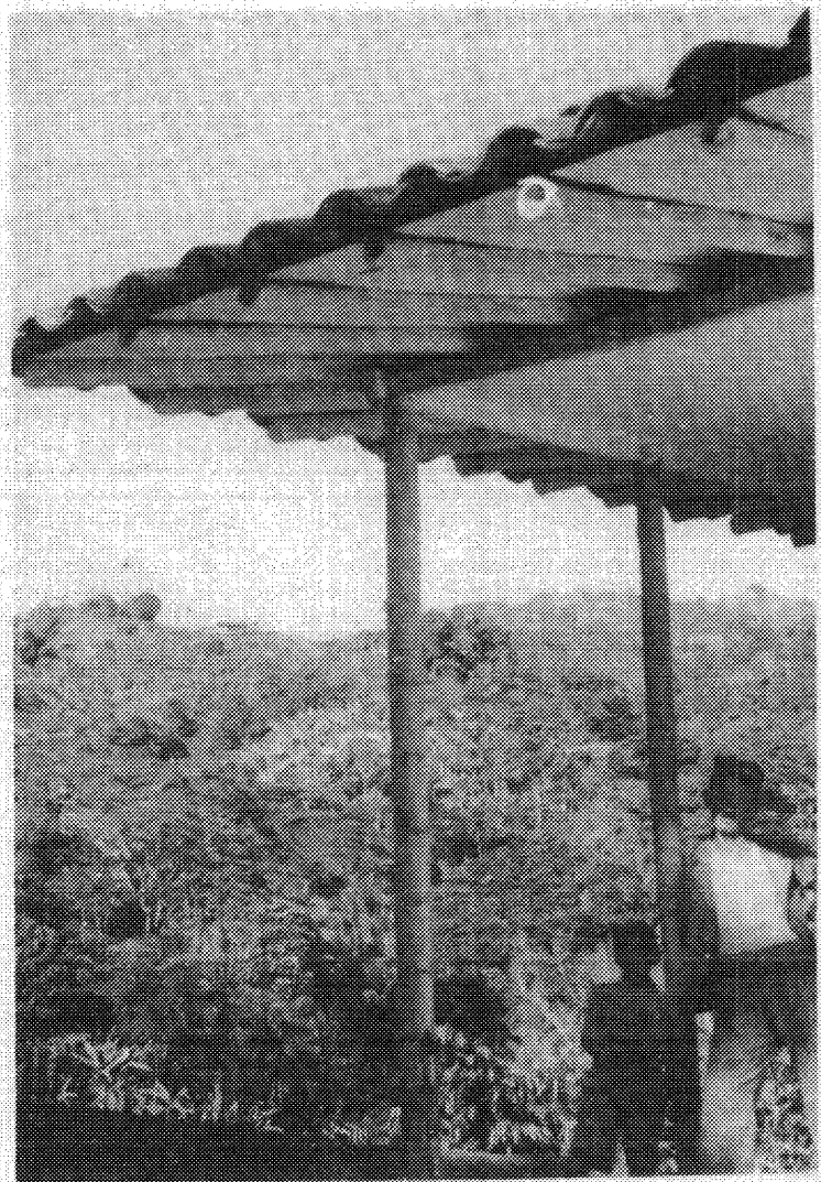
Figura 22. La estructura de este techo de bambú es típica en el Departamento de Caldas, Colombia. La uniformidad ha ido en aumento con largos años de uso; siempre ha sido el bambú el material de construcción preferido en la región, desde la época colonial.
