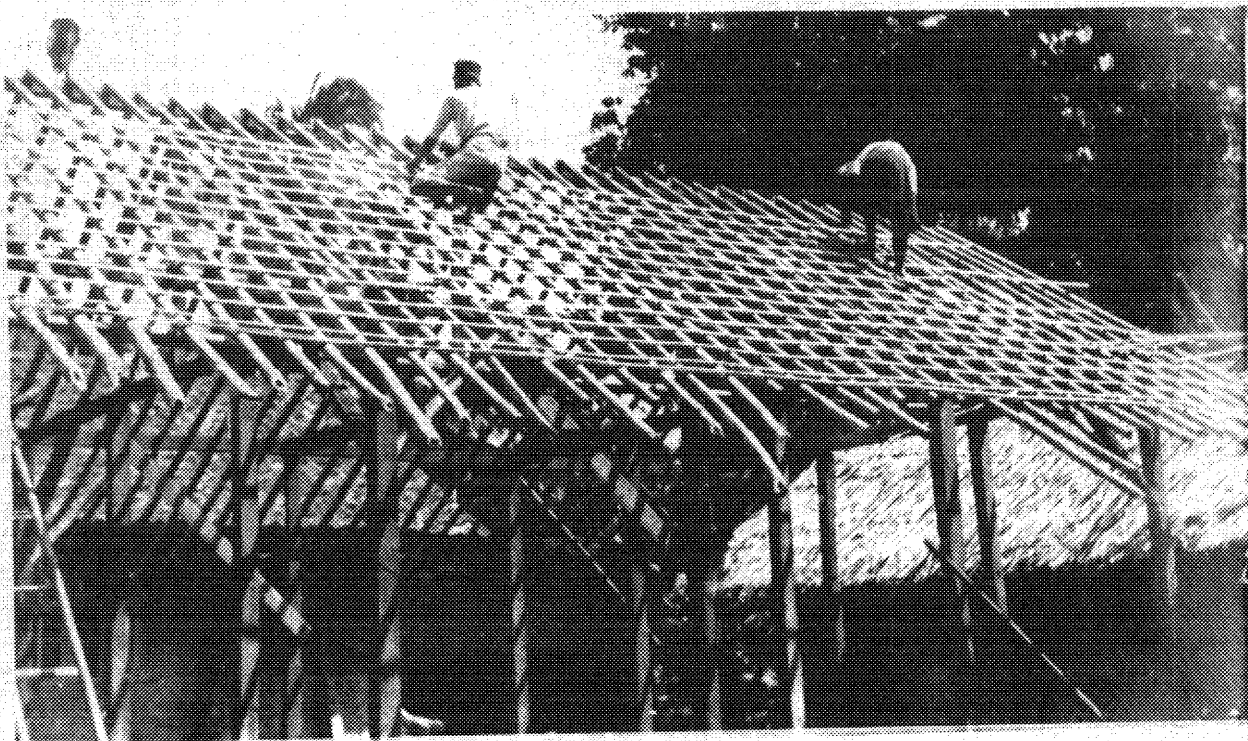
Figura 4. El armazón de esta casa, que se construye en Java, es de madera maciza, pero cabrios, entramados, andamios e, inclusive, escaleras, se hacen de bambú. Los muros y mamparas se pueden recubrir de una estera de bambú; generalmente, en Java se emplea la especie Gigantochloa para este propósito. (Foto de Dorsett.)
