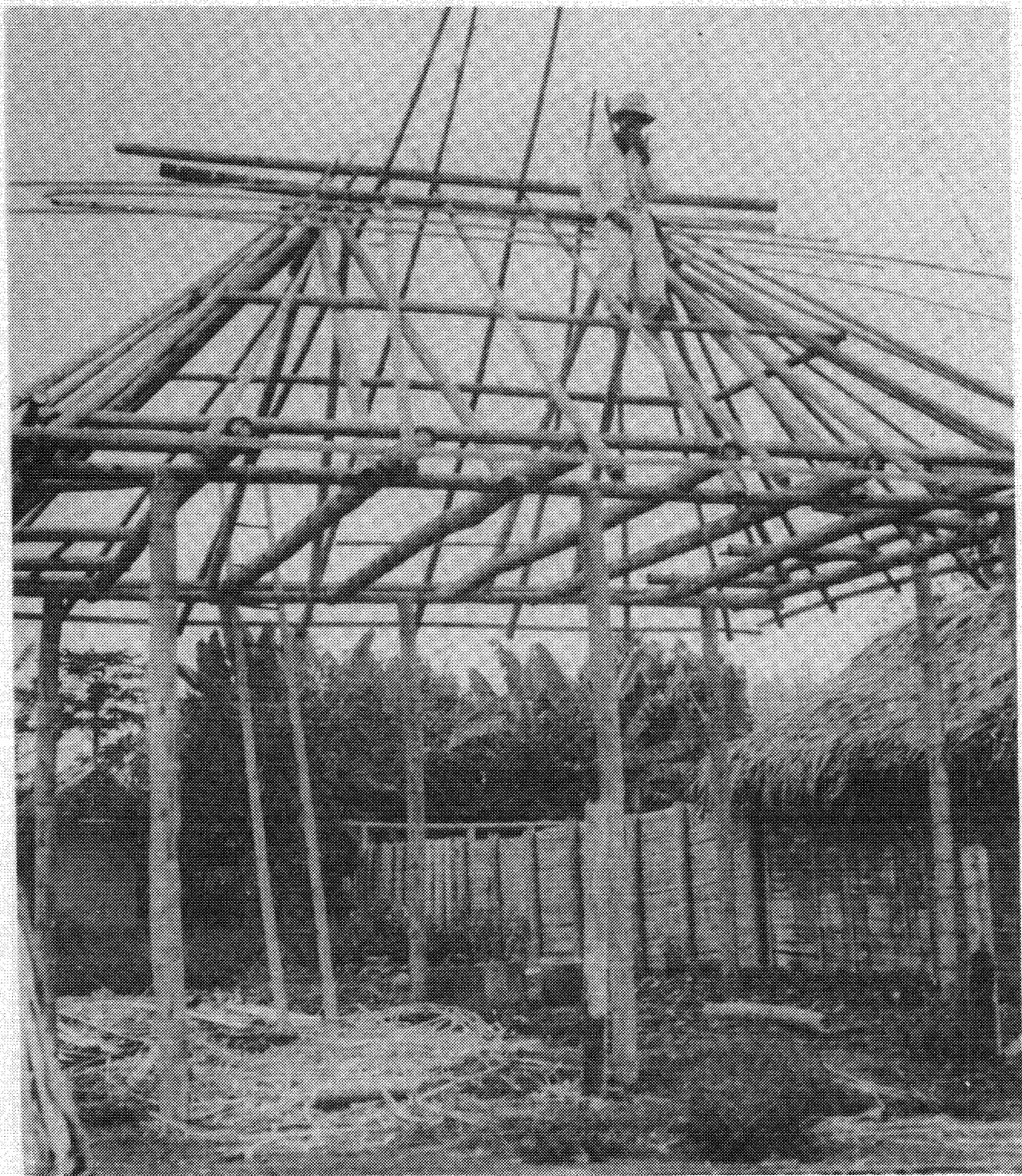
Figura 5. El bambú se utiliza para construir el armazón estructural de la barraca de un campesino en Colombia. Los muros y mamparas se hacen de tablas de bambú. De hecho, todos los materiales empleados, excepto el techo, provienen de la especie nativa Guadua angustifolia ; las cañas de esta planta tienen forma y tamaño tales, que para su empleo se requieren únicamente las herramientas más sencillas.
