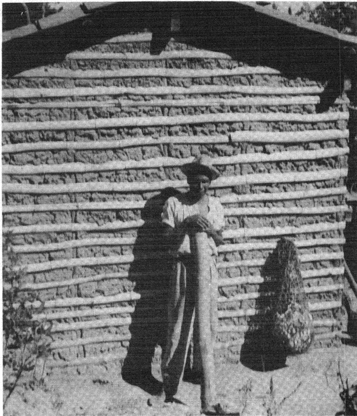
Figura 12. Las tiras de bambú sirven de apoyo y protección a esta pared de adobe, en El Salvador. En muchos países latinoamericanos, este tipo de construcción se denomina bajareque . En El Salvador, el bambú común, Bambusa vulgaris , se puede conseguir en cualquier parte, con excepción de las regiones más secas, y sus cañas constituyen un material que suele emplearse para muchos usos.
