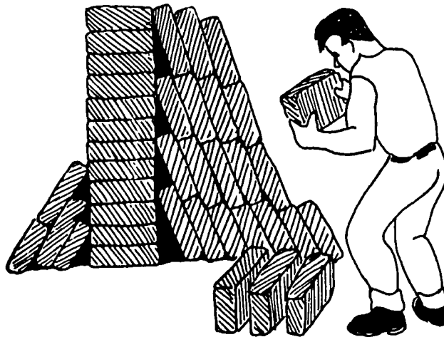
46. On empile les blocs d'adobe après un mois de cure.
