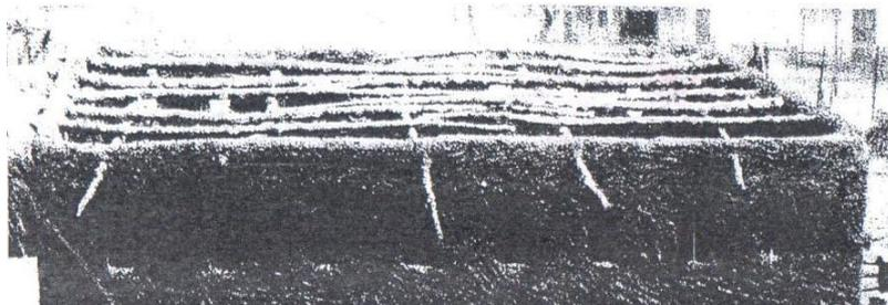
Pour donner au toit la pente, les deux côtés de la chèvrerie rectangulaire n'ont pas la même hauteur. Le côté ouest possède 10 rangées de briques et le côté Est seulement 8 rangées.
