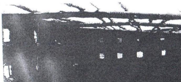
**Toiture circulaire :** La construction du toit dans le cas du modèle circulaire est du type traditionnel. Les perches de grosseur moyenne sont disposées en rayons, les tiges flexibles sont réunies en lattis concentrique et assemblées par des cordes.
