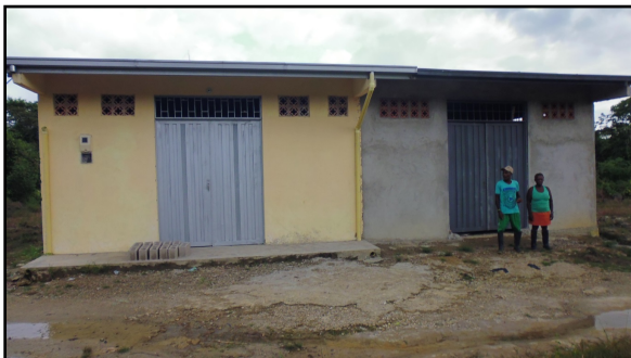
Vista panorámica del centro de Acopio, localizado en el casco urbano del corregimiento de San Isidro, Municipio de Quito, Departamento del Choco.
