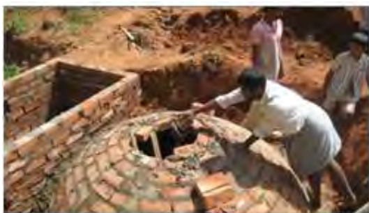
Photographie 14-a : Construction d'un réservoir à biogaz en Inde. Valorisation des déchets animaux pour la production d'énergie.
